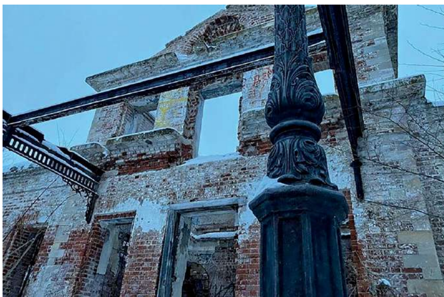
Фотография парадного входа усадьбы | рис. 49
